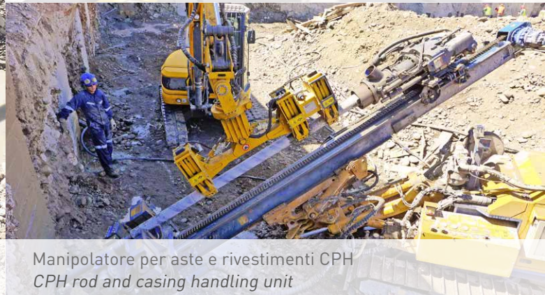
Perforatrice speciale MC-S 12 su piattaforma progettata per l'esecuzione di compensation grouting all'interno di pozzi Special unit MC-S 12 designed to perform compensation grouting inside shafts.
